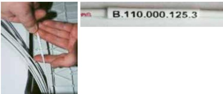
Abbildung 25: Beschriftung Inhouse-Glasfaserkabel mit der OTO-ID und Flat-ID
