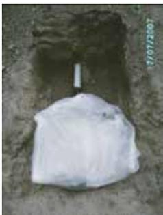
Abbildung 3: Kabel in Kabelschuttsack im Erdreich abgelegt
