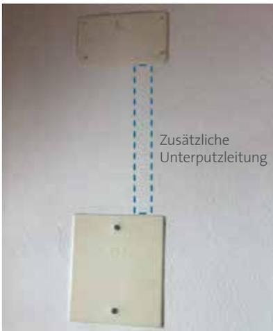
Abbildung 39: Unterputzinstallation Rohr
